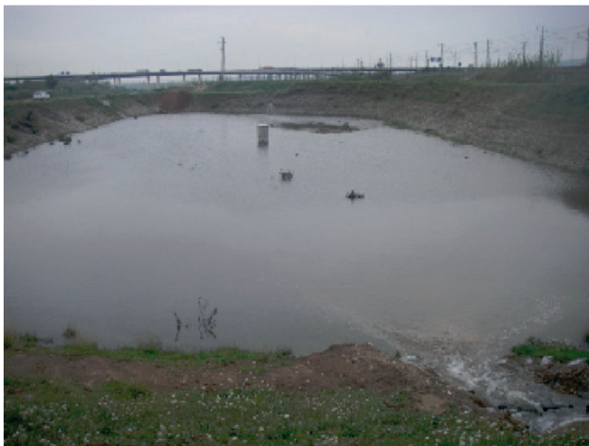
FIGURA 5. Bassa d'infiltració (RGA) a Sant Vicenç dels Horts. Fotografia: Xavier Sanchez-Vila.
